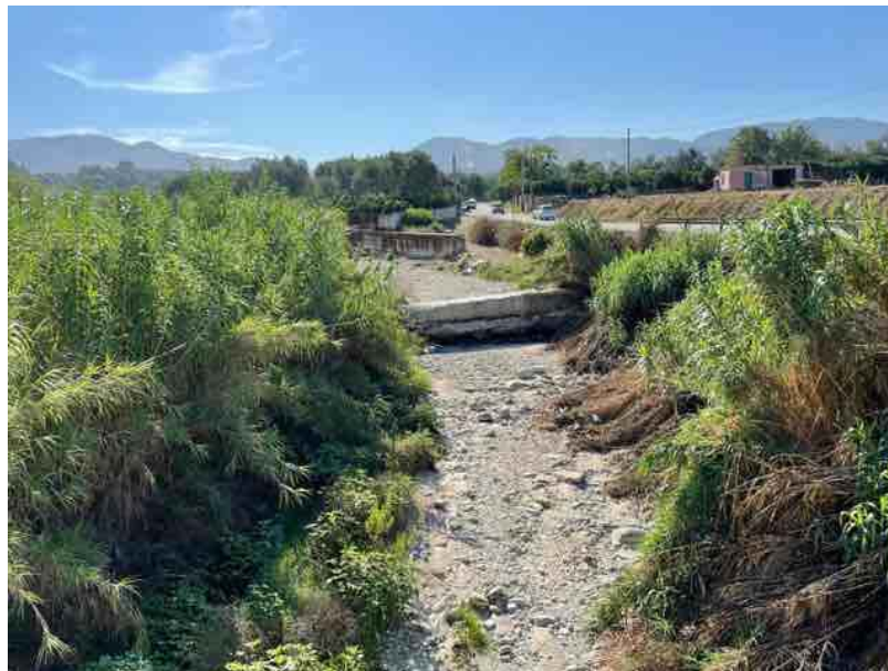
Alluvioni torrente Sciarapotamo
